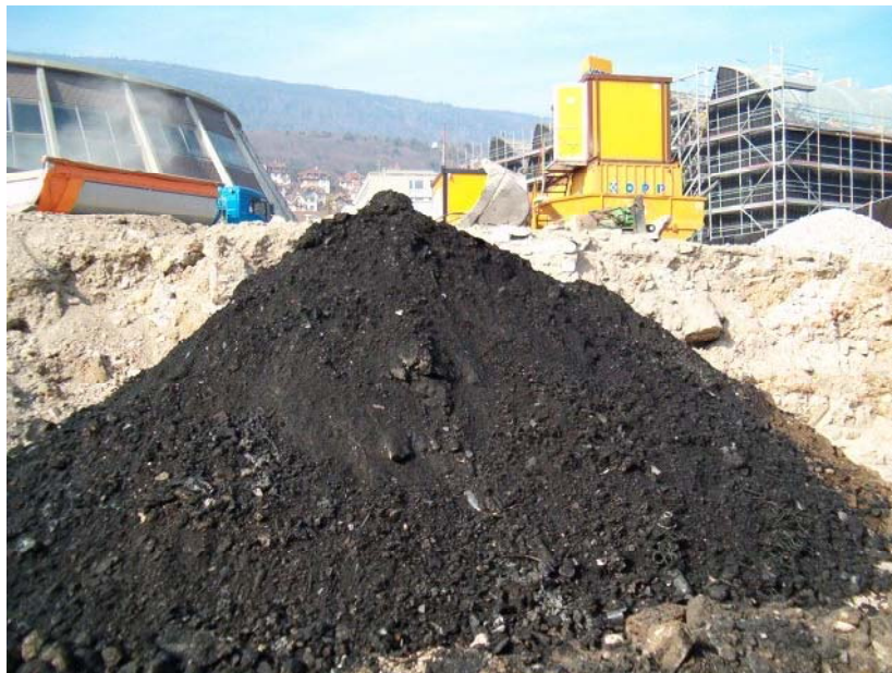
Matériaux pollués (excavation du centre de la Maladière à Neuchâtel)
