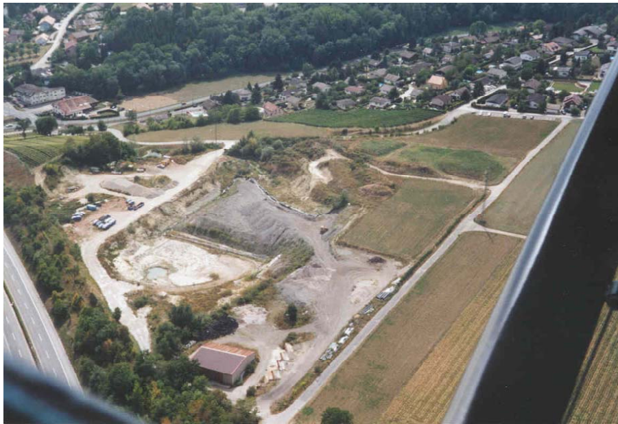
La décharge bioactive pour scories de " Sur Crusilles "à Valeyres-sous-Montagny
