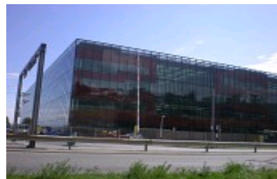
EIE du centre R&D de Philip Morris International à Neuchâtel 2007-2008
